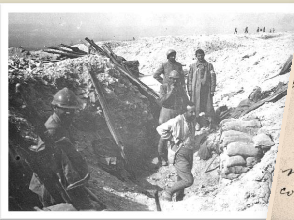
Poste de secours (photo de JL BARRES)
